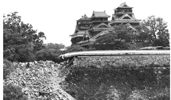
平成 28 年 4 月の熊本地震で被災した熊本城
